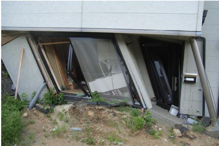
地盤が右へ滑ったため、柱の下の方が右へずれている
