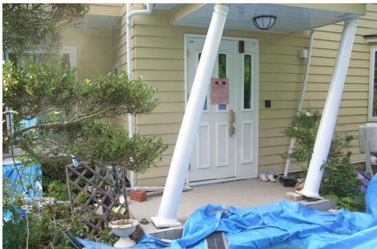
ベタ基礎でしっかり工事しているため、滑って傾いただけのお宅は、一部損壊扱い。傾斜を見て大規模半壊にする基準は作ったが、評価判定調査が追いつかないため、未だに改善なし
