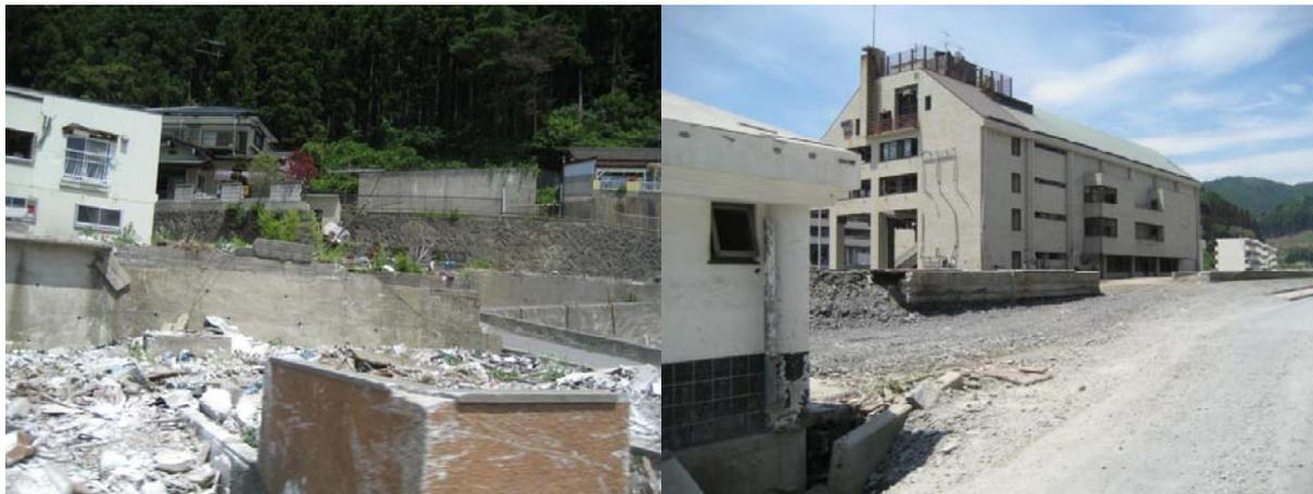
万石浦を通り過ぎ、牡鹿半島の根元の丘を東に超えると女川町。牡鹿半島東岸では、女川町だけが残り、北側の雄勝町などは石巻市に統合された。女川では津波の威力のものすごさを実感。高台にある女川町立病院の地面（HPでは標高 16 m の 1 階部分も津波で破壊を受けている）と同じ高さのビルが基礎杭ごと横倒しになっている。A 氏曰く「屋上に車が乗っていた」とのこと。まさに女川では、「津波が丘を超えた。」（左写真）
