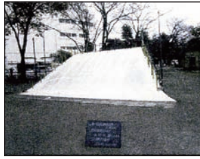
幅広滑り台 改修
