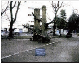
コンクリートの木 撤去
