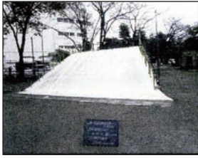
幅広滑り台 改修
