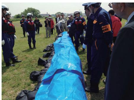
シートを併用した改良積み土のう工法で越水・浸水を防止する。
