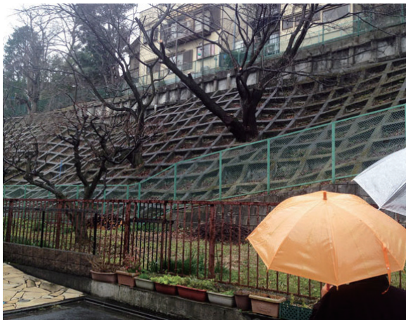
急傾斜地崩壊危険区域として対策がとられた赤羽西2丁目の崖地。140mにわたって工事がおこなわれています。
