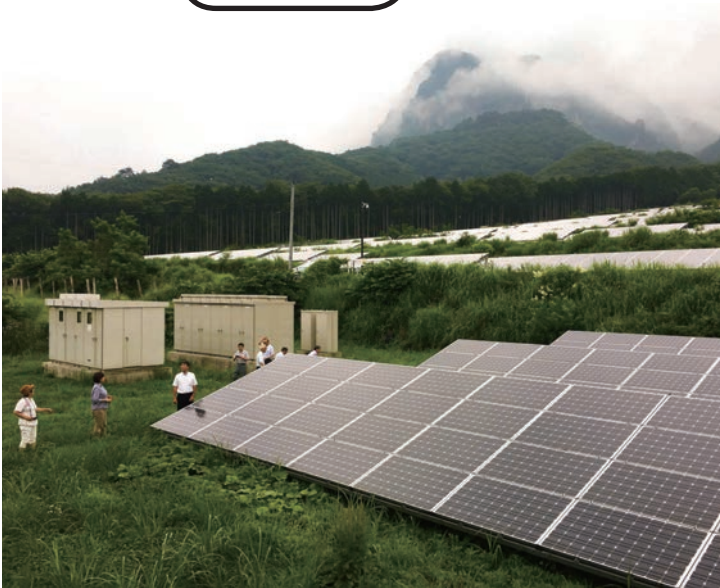
9380枚のソーラーパネルが設置された沢渡温泉第1太陽光発電所
