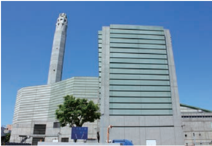
志茂1丁目の北清掃工場
