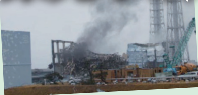
煙をあげる福島第1原発3号機 ＝3月21日午後4時10分（東京電力撮影）
