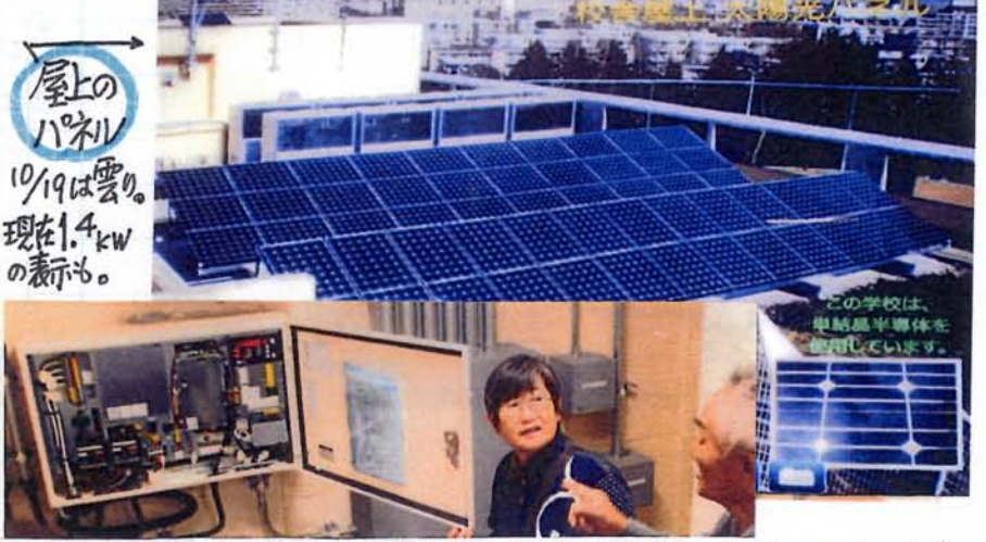
↑太陽光発電の直流を交流電気に変える装置です。(パワーコンディショナ)
