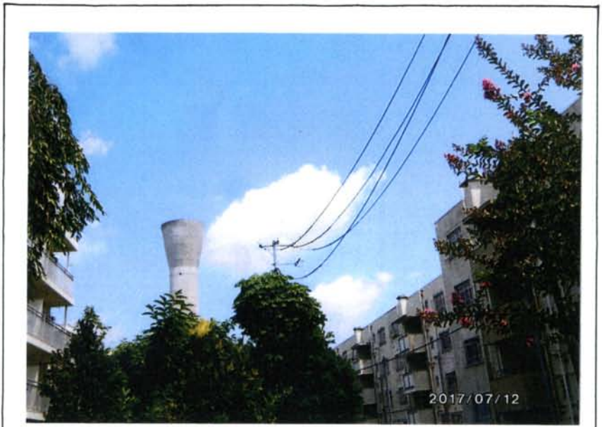
もうひとつの給水塔と夾竹桃 桐丘団地N地区
