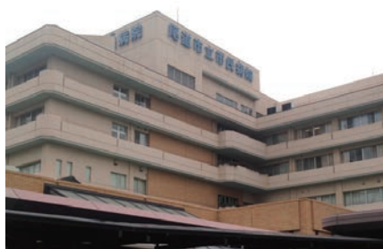
尾道市立市民病院の外観
